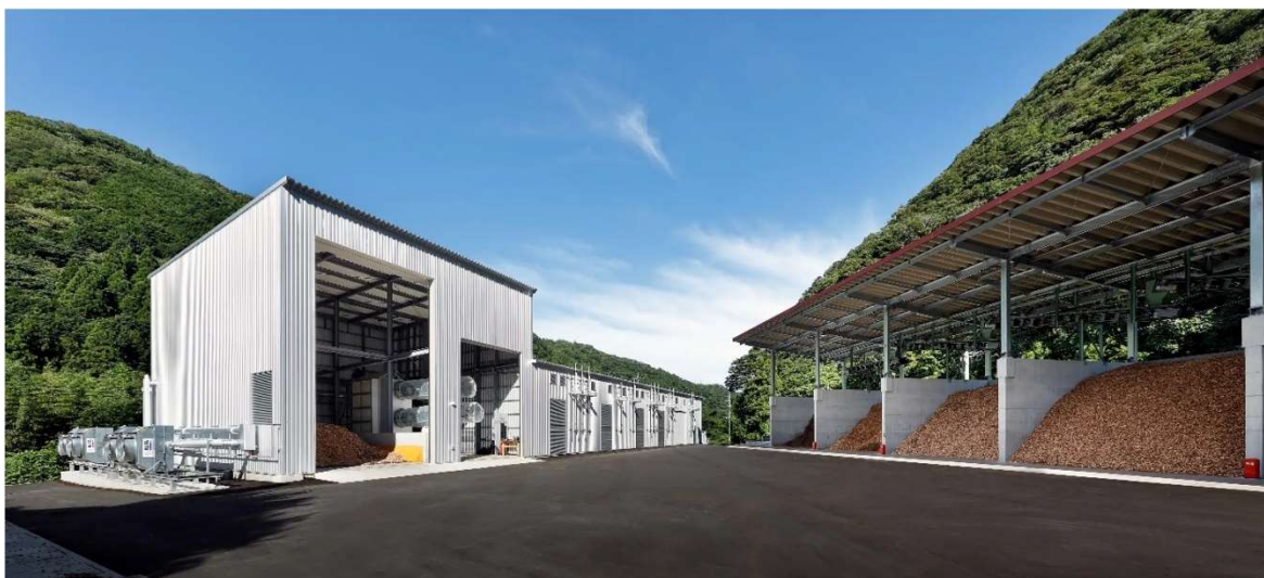
導入されている発電機（「Volter 40 Indoor」）
