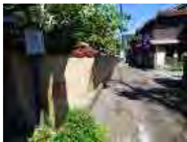
ろうそく型断面の土塀
