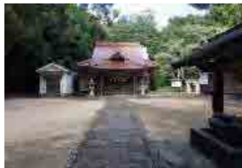
三渡八幡宮本殿
