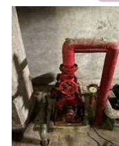
老朽化した消火ポンプの更新
