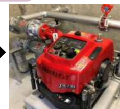
老朽化した消火ポンプの更新
