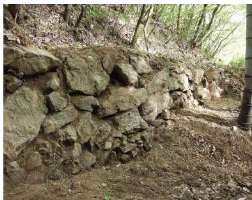
街道の山側の石垣。石垣の手前（左手）下部は土が流出し、石垣の基礎が露出していると考えられる
