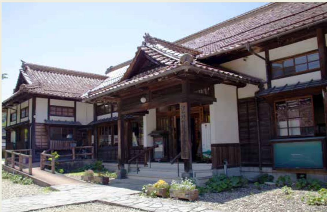
耐震補強・改修工事前（令和6年5月撮影）
