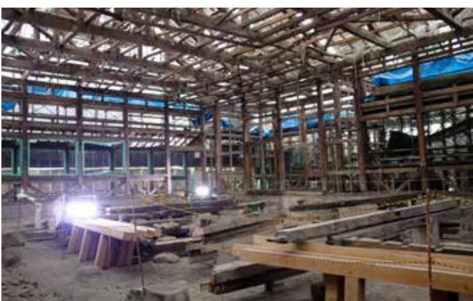
耐震補強・改修工事の様子（令和7年2月撮影）
