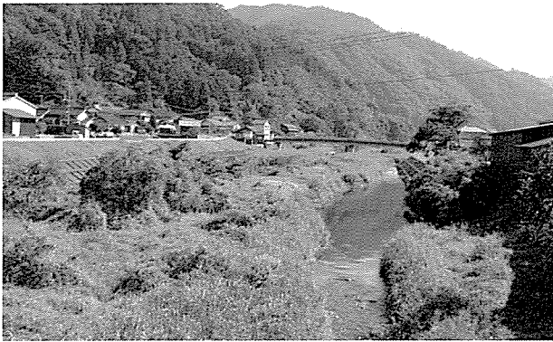
高津川合流付近の津和野川 河川浄化と河床掘削はいつ？
