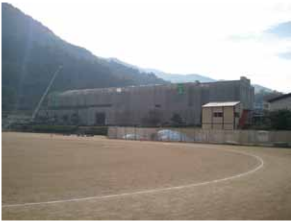
耐震補強、改修工事中の津和野中学校校舎 工事期間は今年 12月28日まで
