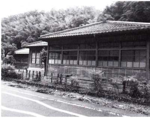
復元工事中の畑迫病院
