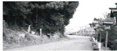
⑤町道城山線改良工事 一部を拡張し登山者のたまり場となる
