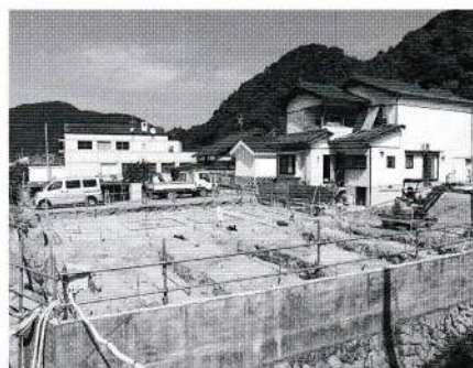
建設中の日原図書館
