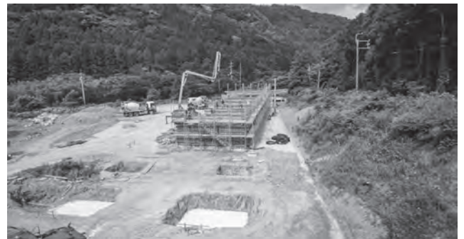
チップストックヤードの建設現場「6/14撮影」
