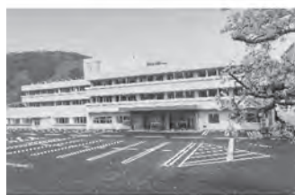
完成した新庁舎
