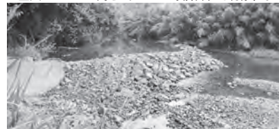
江戸時代？ 創出で現存する 野積石堰 高さ1.7m 鴨御獵場 全長40m 幾久井堰
