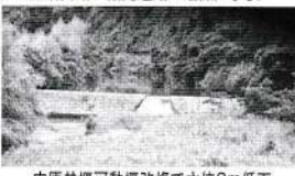
中原井堰可動堰改修で水位2m低下
