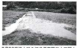
8月29日増水時の畑迫保育園前水田冠水
