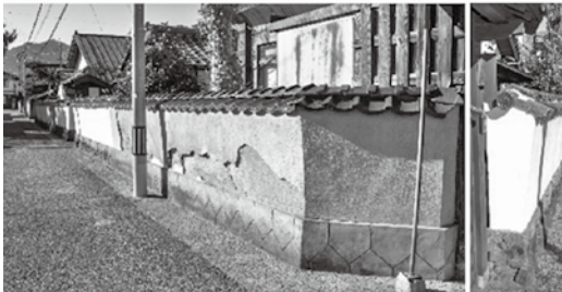
上新丁通りの土色蝋燭塀100m 歴史的情緒あるも風化が進み崩れている
