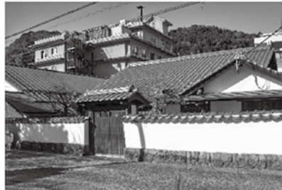
町屋ステイ上新丁の漆喰塀10m 伝統的建造物群保存地区内の風致に不調和
