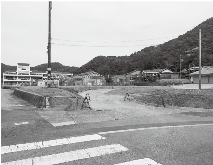
解体が完了した建設予定地
