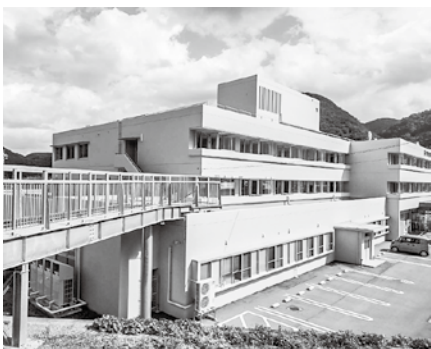
本庁舎3階(外観)
