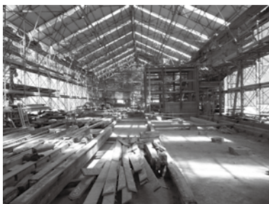
修復工事時、解体された畑迫病院
