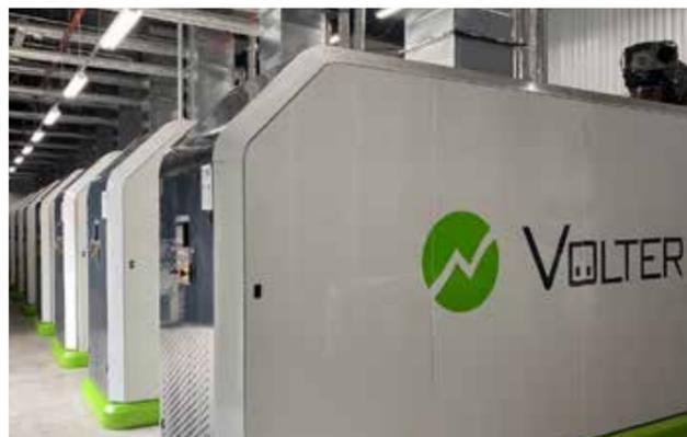
小型バイオマスガス化発電プラント Volter40
