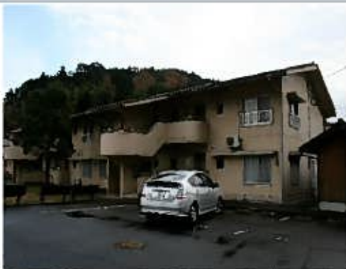
特定公共賃貸枕瀬団地（耐火構造二階建）
