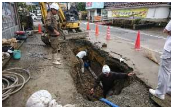
漏水工事の現場
