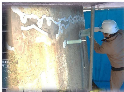
写真4-2 ひび割れ注入状況
