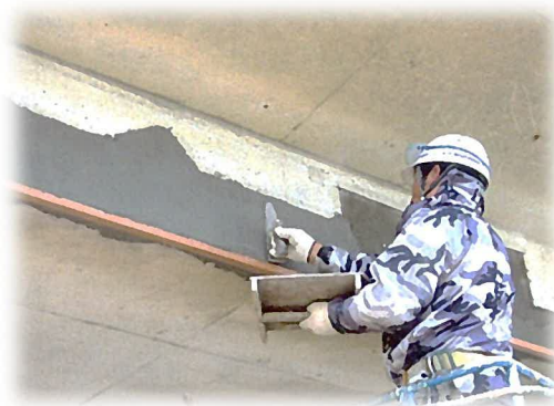
写真4-3 断面修復状況
