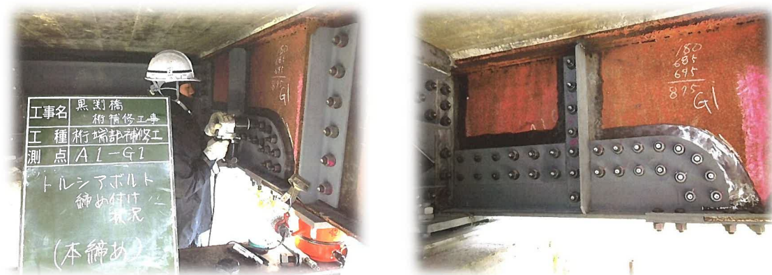
写真4-1 当て板工実施状況
