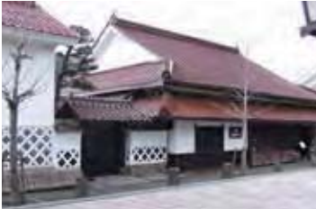
① 田中家店舗兼住宅（沙羅の木） 明治中期の建物で、田中氏は昭和に入ってから呉服店を営んだ。正面の開口部に改変が見られるが、全体として建設当時の様式を残している。座敷に面した庭園もすばらしい。
