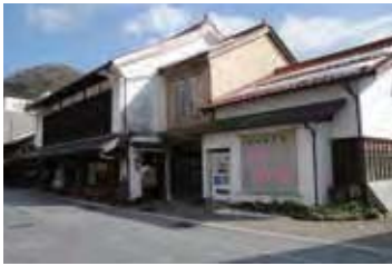
⑧ 古橋酒造場（登） 大正年間築の酒屋。明治初期の創業で併設された擬石張りの洋館の一部が残る。本町通りに直行した横町通りに白壁と板張りの土蔵を配置して敷地を囲んでいる。
