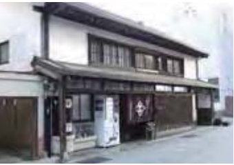
⑤ 分銅屋七右衛門本店（椿家）（登） 嘉永6年（1853）の大火直後に建てられた保存地区内最古の商家建築。建物が通りに対してわずかに振れ、座敷に面した中庭や背面の土蔵が江戸の町屋の特徴を残す。
