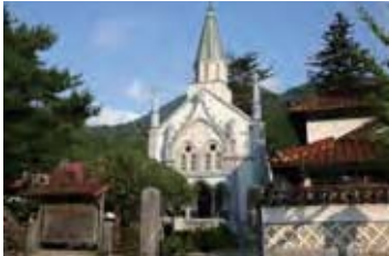
② カトリック教会（登） 町年寄の堀氏宅の跡に昭和6年に建てられたゴシック風建築の教会。敷地の背後には神父館も残る。
