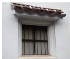
主屋小窓・小庇
