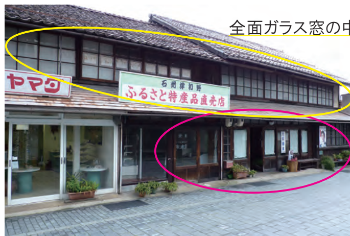
漆喰の塗籠 防災のため家屋の側面側には漆喰を軒の部材が隠れるように塗っています。
