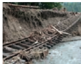
豪雨の影響により土台となる地面が大きくえぐり取られたJR山口線（平成25年8月9日撮影、名賀）
