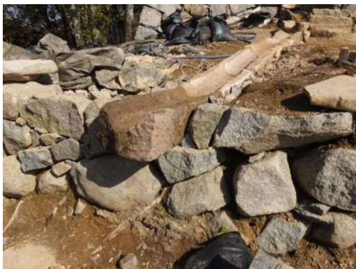
〔水路工事作業写真:3/23撮影〕
