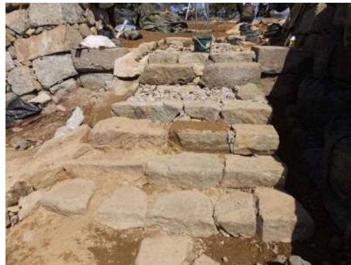
〔石段工事作業写真:3/23撮影〕
