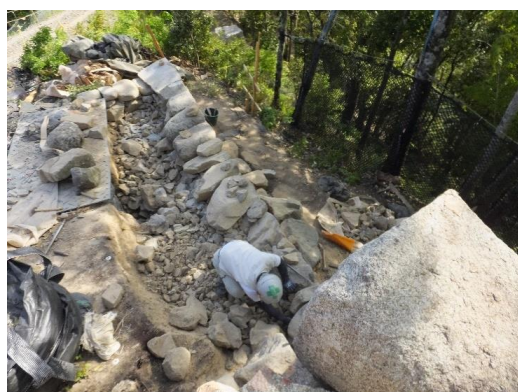
[石垣石積作業写真:5/14撮影]
