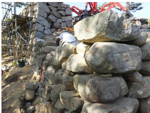
[石垣石積作業写真:5/12撮影]
