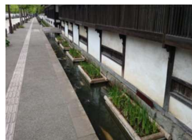
殿町水路整備後
