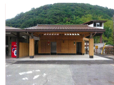
駅舎内トイレの改修後
