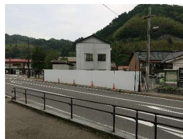
SL館解体後
