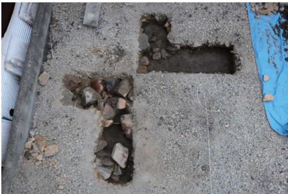
個人邸新築工事に伴う事前の試掘確認調査
