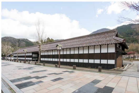
〔武道場完成写真:12/27撮影〕
