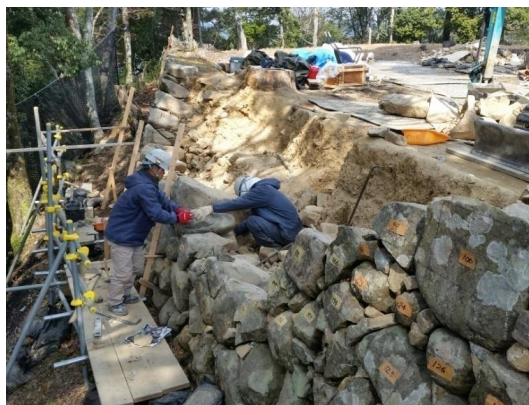
[石垣解体作業写真:2/23撮影]
