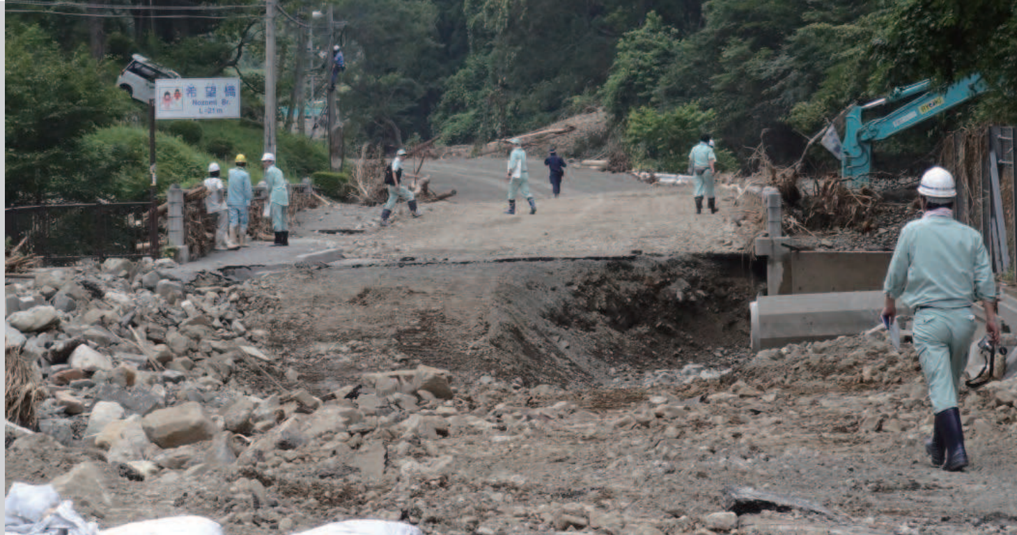
豪雨により崩落した県道 13 号（萩津和野線）希望橋手前での復旧作業の様子【平成 25 年 8 月 5 日撮影】
