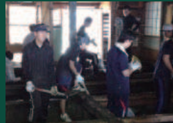
床下の泥出しは機械を入れることが難しいため、たくさんの人手が必要です。
