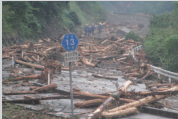
7月29日に撮影された県道13号線(萩津和野線)。道路が冠水し、流れ込んだ土砂や木がそのまま残された。奥の方では路面が土砂で完全に覆われている。
