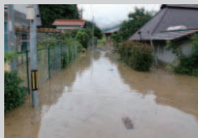
道路の冠水により家屋も被害を受けた
