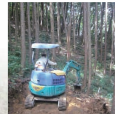
自伐林家による作業路開設の様子
