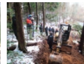
バックホーによる作業路開設研修
